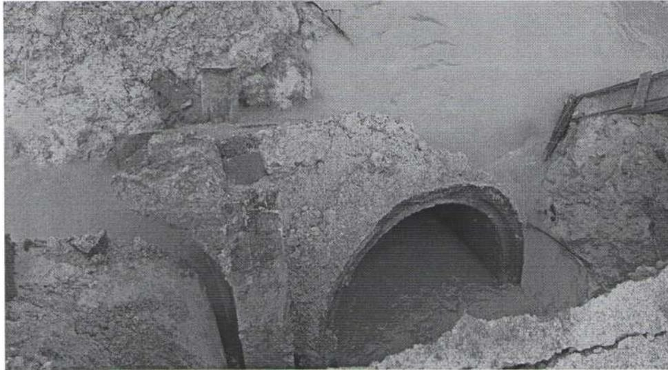
FIGURA 09: ESTRUTURA DE BUEIRO DESTRUÍDA POR ENXURRADA, VICINAL 08, PA TABOCA.
