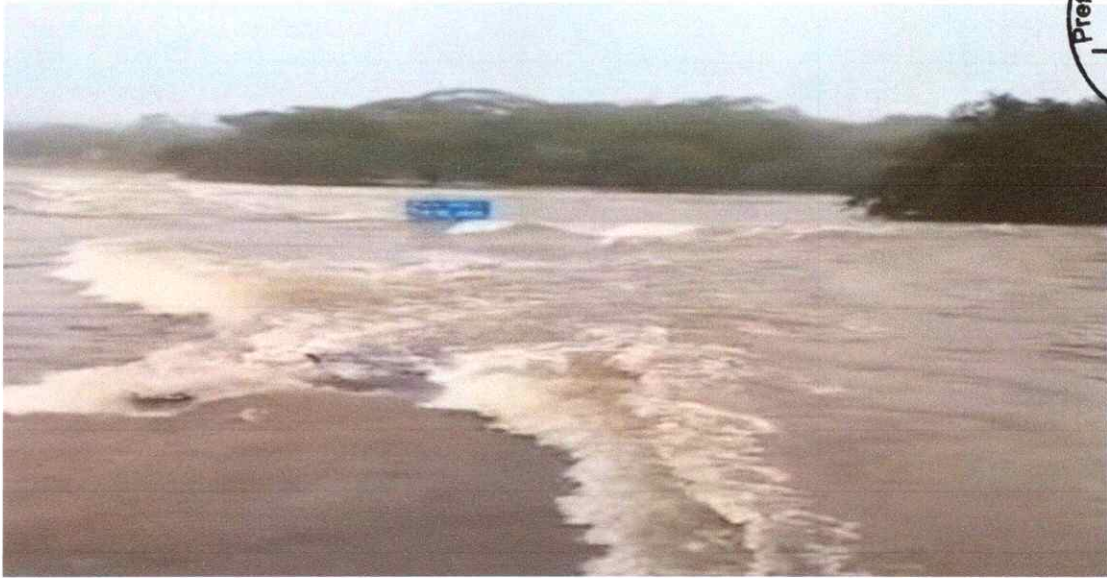
Figura 10: Trecho da BR-432, próximo ao rio Baraúna, no município de Cantá, interior de Roraima.
