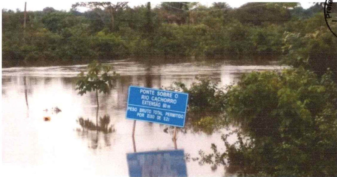
Figura 02: Ponte Sobre o Rio Cachorro na BR-432, no Cantá, interior de Roraima.
