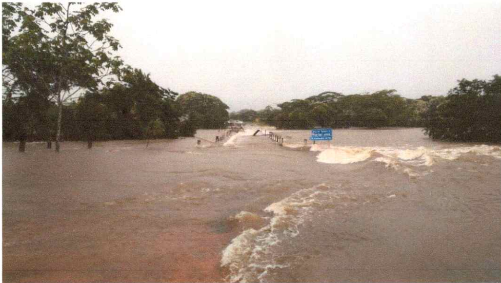
Figura 05: Ponte sobre o Rio Baruana
