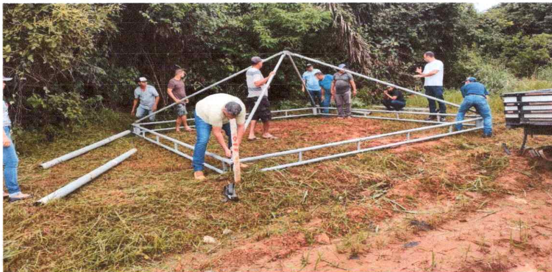
Figura 03: Prefeitura de Cantá, interior de Roraima, monta bases de apoio para dar suporte a população em locais interditados por conta das chuvas
