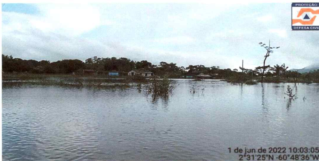
Figura 08: Trecho interrompido na Vicinal Rio Branco
