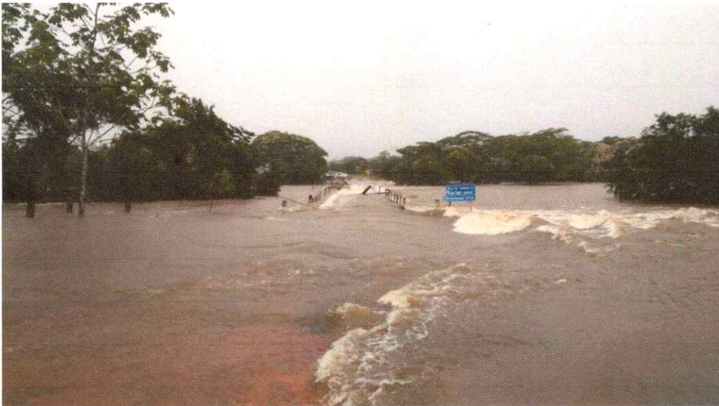
Figura 05: Ponte sobre o Rio Baruana
