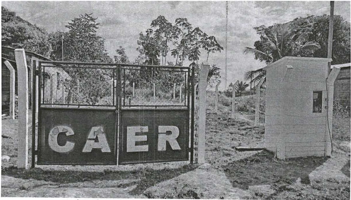
Local previsto para construção do reservatório
